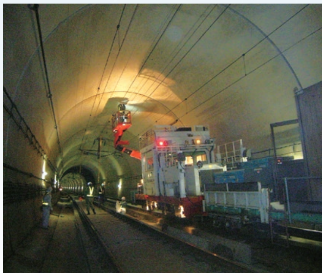
鉄道トンネル
