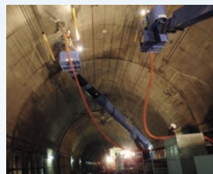
鉄道トンネル
