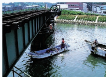
水中打設状況
